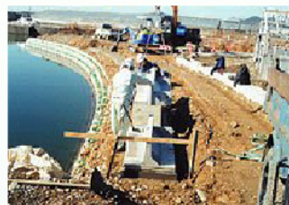
2. 製品の布設状況
