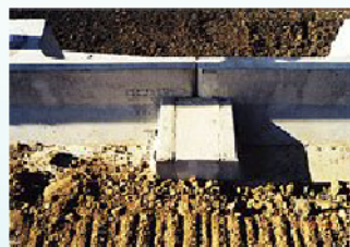
5. 間詰コンクリート打設
