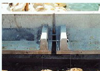
4. 連結鉄筋接続工
