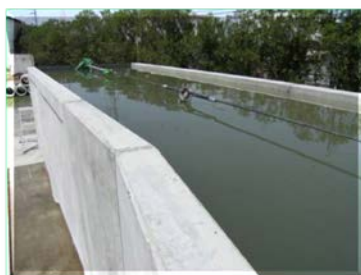
変位後の漏水なし
