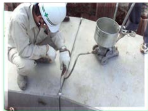
注入口より側壁部・底版部へ注入
