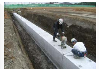
長尺PRC 600×600×4000 長尺ボックスカルバートへの適用例
