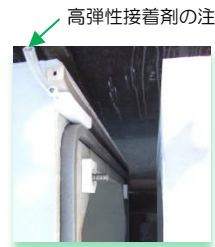
上面から下方を見る
