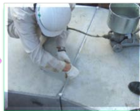
上部より頂版天端部へ注入
