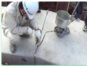
頂版から注入
