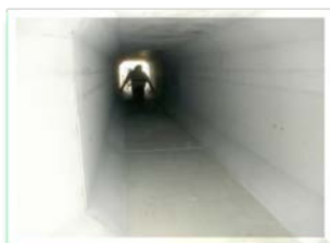
内部の状況 曲線部も直線部と同じ施工！
